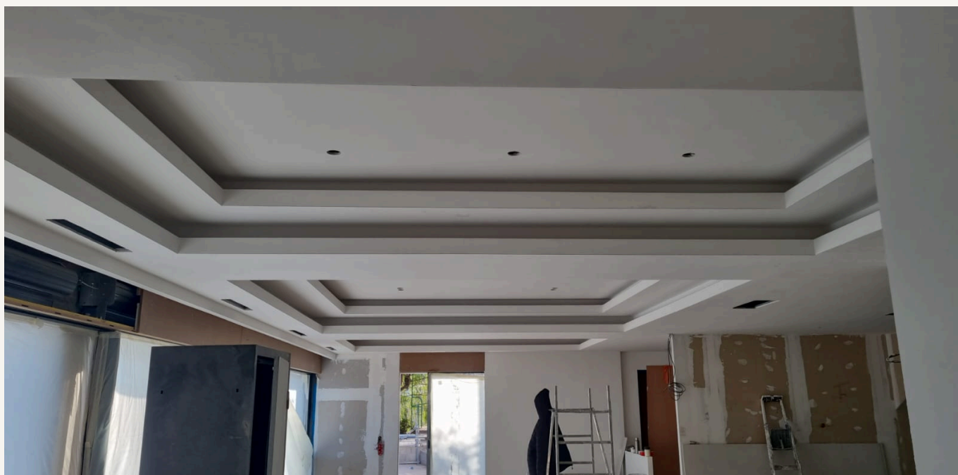
FAUX PLAFOND À REDENTS, EN COURS DE PLÂTRERIE.
